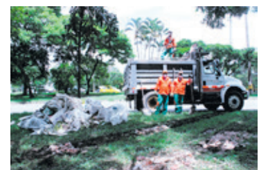
Diariamente en el centro de Medellín se arrojan entre 5 y 7 m 3 de escombros.
