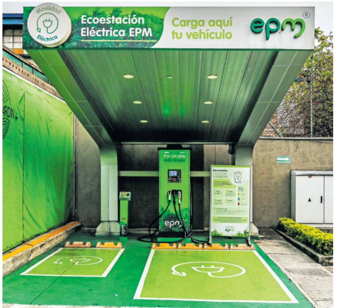
**Las estaciones de carga rápida demoran veinte minutos en cargar el 80% de la batería del auto, mientras que las de carga lenta unas cuatro horas en cargarlo en su totalidad.**
