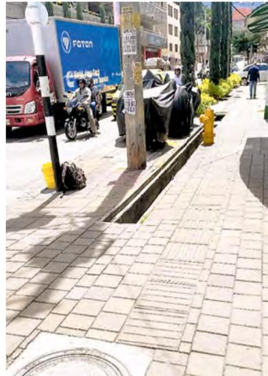
Muy cerca de mi trabajo, en la calle 59 No. 51e – 71 (Carabobo con Restrepo Uribe), esta zanja que parece ser provocada porque se robaron las rejillas de concreto que tapaban el bajante de agua, ha provocado ya muchos incidentes con transeúntes del sector.
