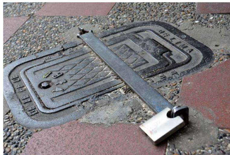
**Instalar platinas de seguridad es un método preventivo que funciona muy bien para evitar el robo de la tapa.**
