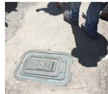
**Este tipo de tapa, fabricada en polipropileno, sería la solución para los robos. La reposición total podría tardar varios años.**
