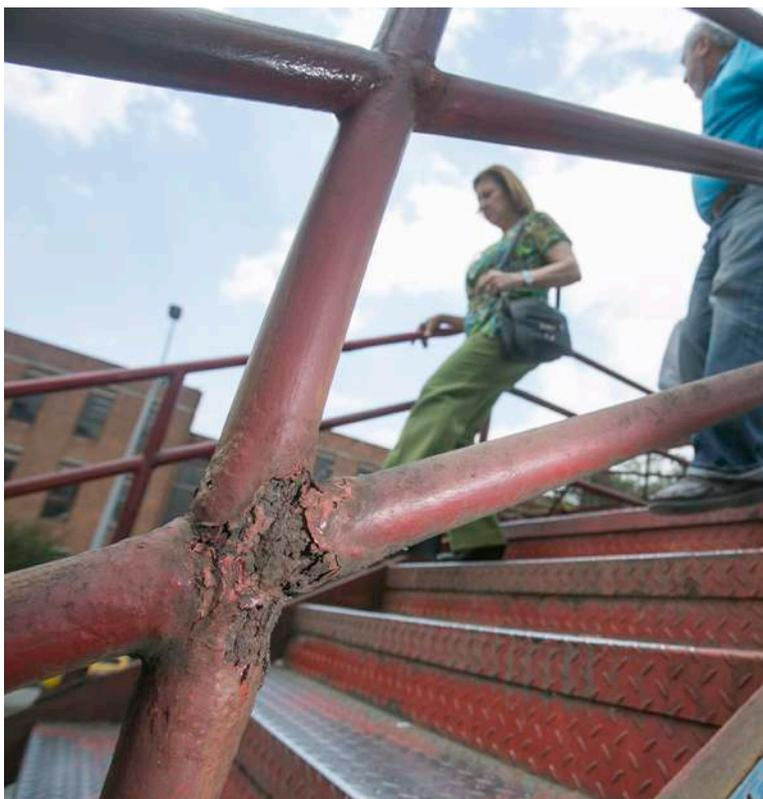
Pasamanos en mal estado, con la corrosión dañando el metal y con peligro potencial para los usuarios.
